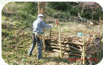
丸太杭使用中
