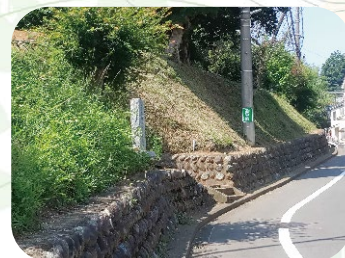
通学路脇の斜面整備
