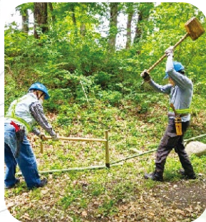
公園内園路柵の杭打ち
